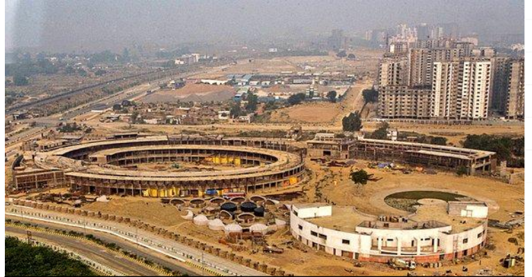
निर्माणाधीन अन्तर्राष्ट्रीय क्रिकेट स्टेडियम।
